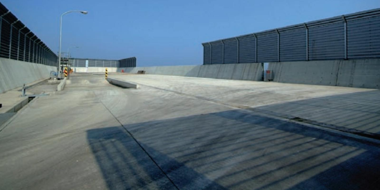
今年6月にオープンした公共岸壁、北九州リサイクルポート。高さ5.5mの防塵フェンスやトラックのタイヤ洗浄施設など、産業廃棄物の荷役に対応した施設が整備されている。
