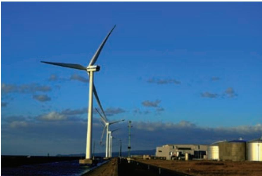
酒田港周辺では、複数の地元企業が設置した風力発電施設が12基稼働。その発電能力は19,300kw（約13,000世帯分の電力消費量）に及んでいる。
